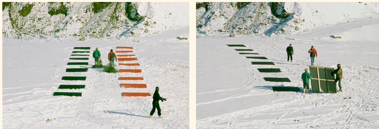
Installation d' Équinoxe
